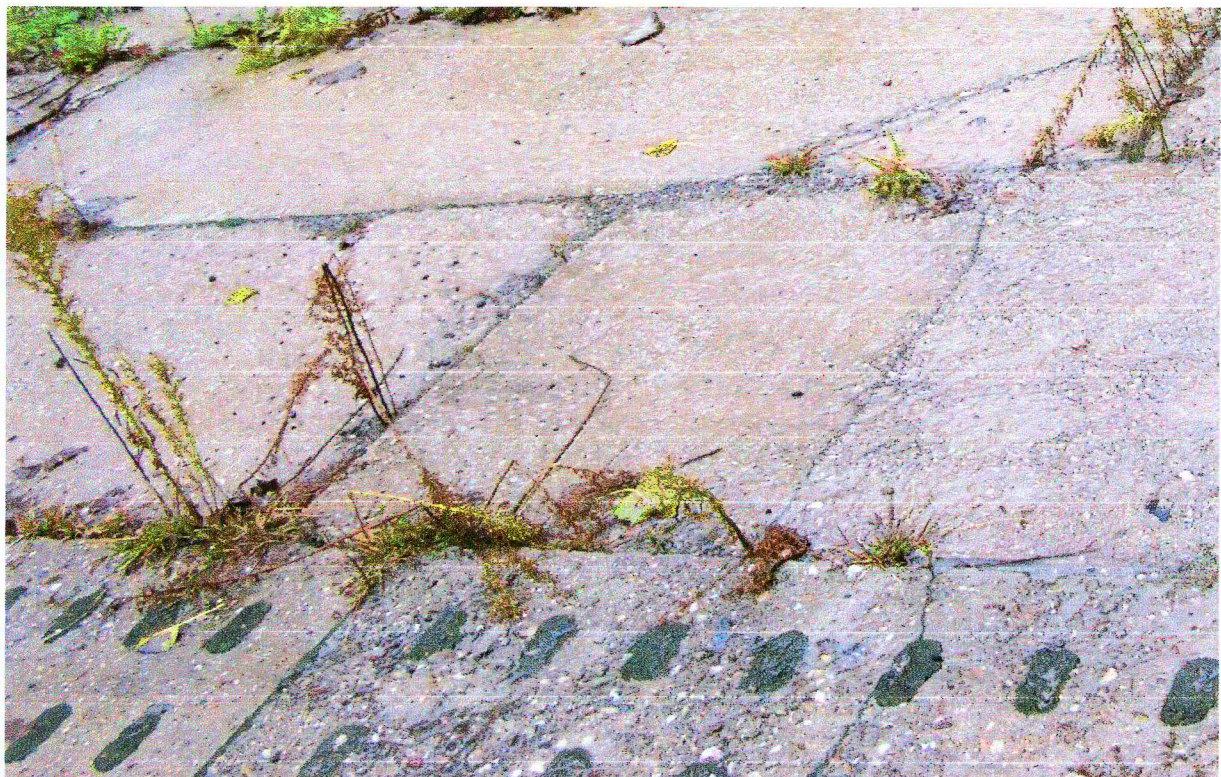
Nawierzchnia z płyt Jomb i z płyt betonowych pełnych- stan techniczny
