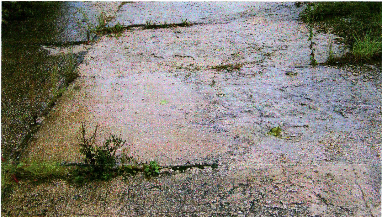
Utwardzenie z płyt drogowych pełnych- stan techniczny
